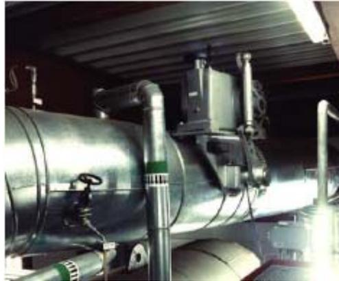
图37 采用角行程执行机构进行空气控制
