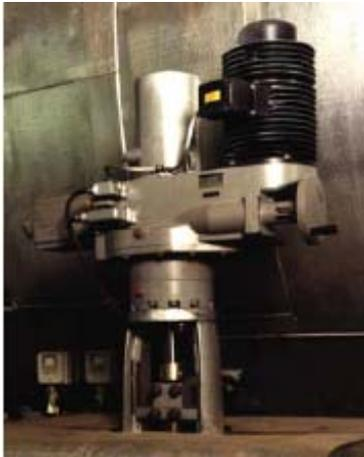
图35 给水预热器上的直行程执行机构
