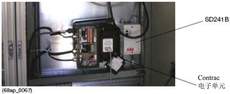
图33 安装在非危险区域中的Contrac电子单元及电机温度监测单元
