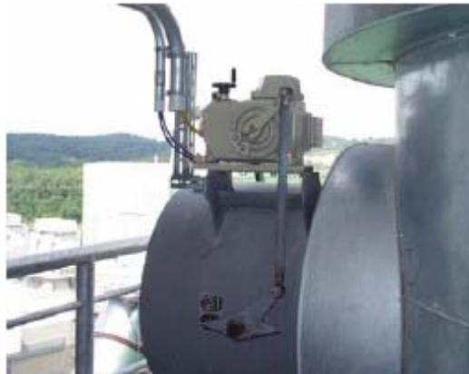
图38 采用角行程执行机构RHDE250（额定扭矩250 Nm）实现碾磨机空气控制
