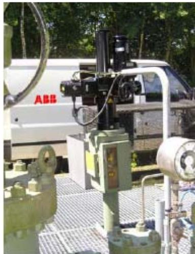
图39 防爆式直行程执行机构RSDE10
