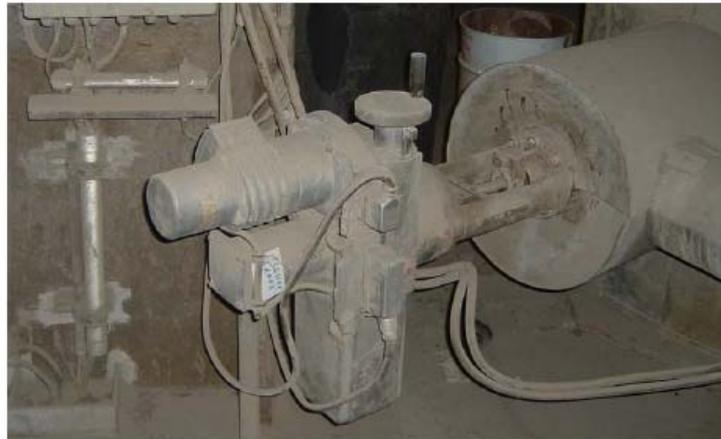
图12 水平安装的直行程执行机构 (Contrac)
