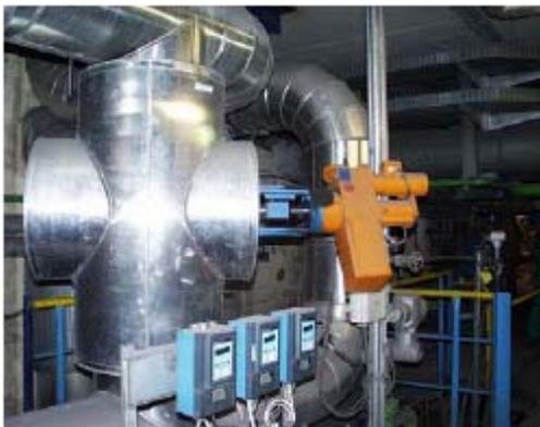
图36 水平安装的直行程执行机构（空气控制）
